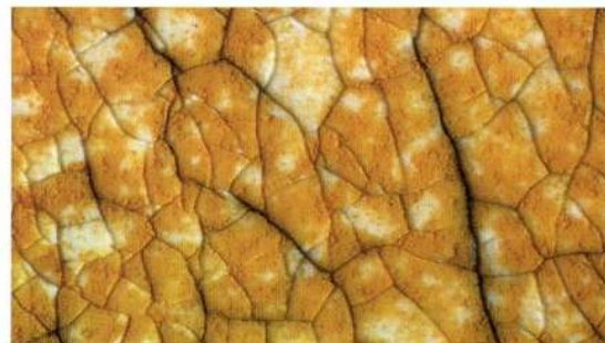
Fig. 5. Revnede og krakelerede fliser.
